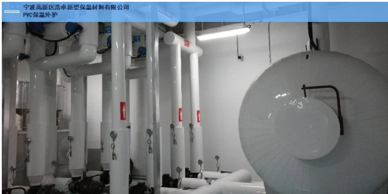
弯头是改变管道管路方向的管件。
